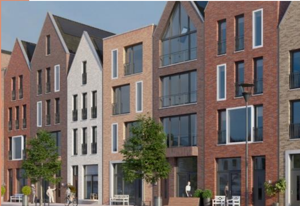
afwisselend hoogteverloop met incidenteel een afwijkende kapvorm
