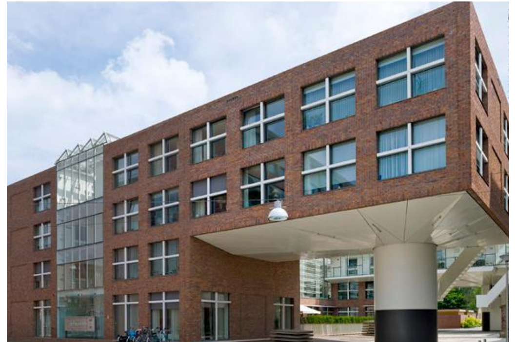
grove detaillering van de vensters met kozijnen achter het metselwerk | De Globe, Nijmegen
